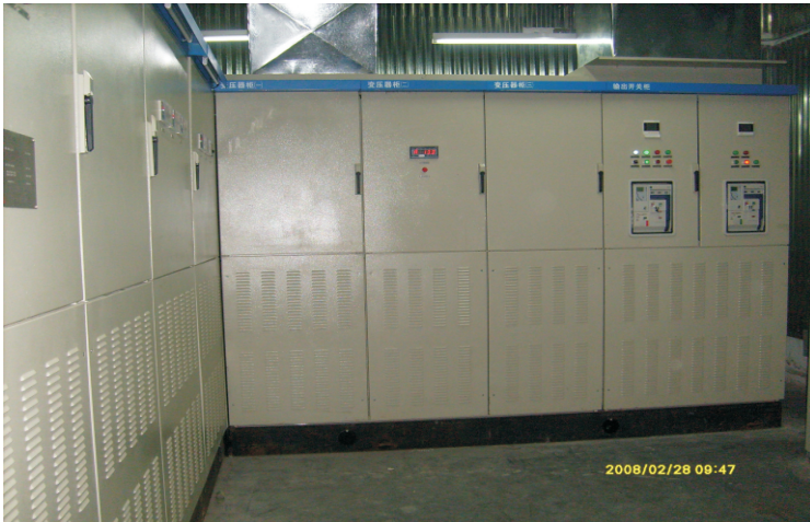
● 开利空调研发管理（上海）有限公司试验变频电源装置1250kVA（一）
